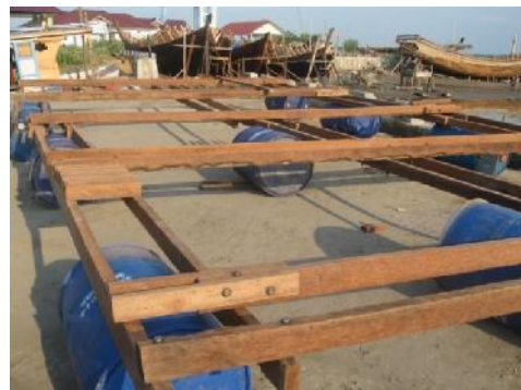
Gambar 4. Pemasangan drum pelampung
