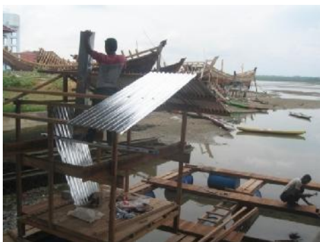
Gambar 6. Pemasangan atap rumah jaga
