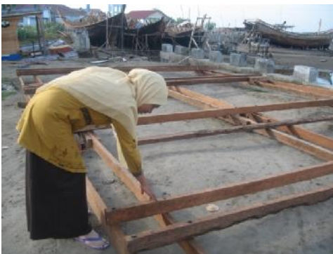
Gambar 3. Kerangka keramba setelah perakitan
